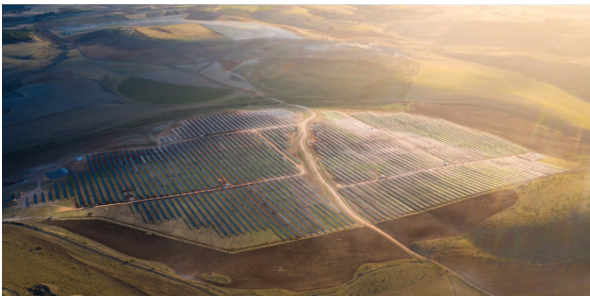
Alarcos Solar Park, 50 MW, Ciudad Real, Castilla-La Mancha.
